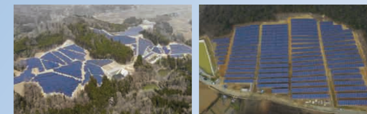
角田市太陽光発電所
